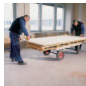
Akustikdesignplatten mit einem Plattenwagen oder hochkant transportieren.
