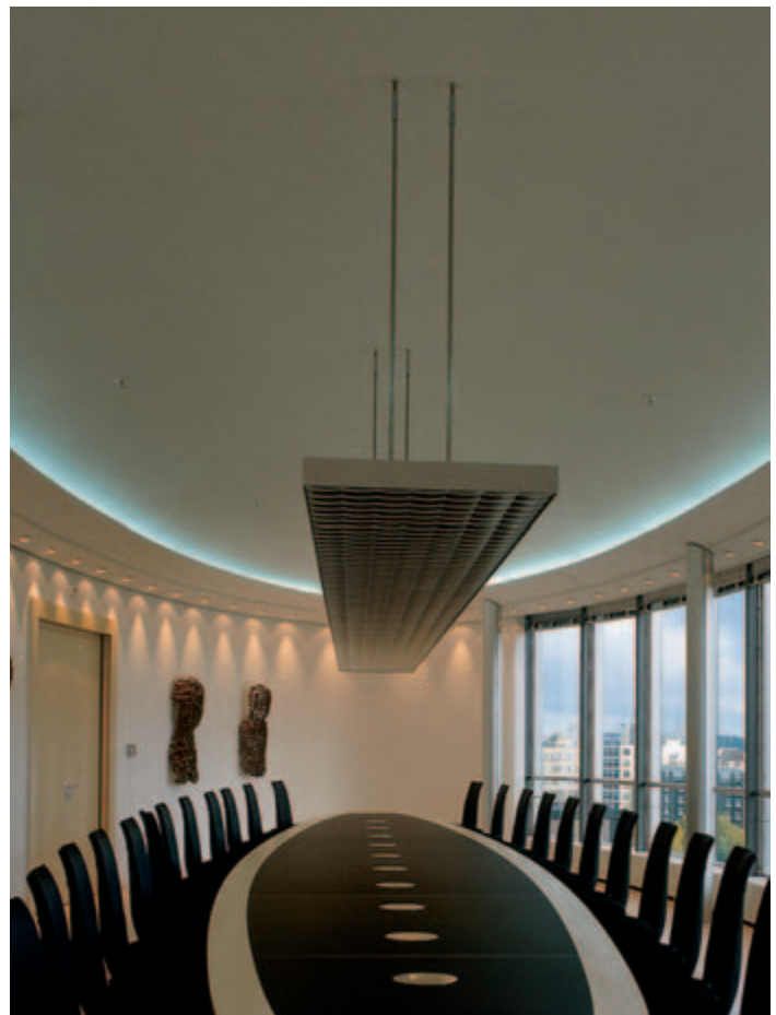
Geschäfts- und Bürohaus am Potsdamer Platz, Berlin Ellipsenförmige Kuppeldecke aus Knauf Platten mit integrierter Lichttechnik Entwurf: Steffen Lehmann Architekten BDA, Berlin Trockenbau: Rogge Spezialbau, Berlin
