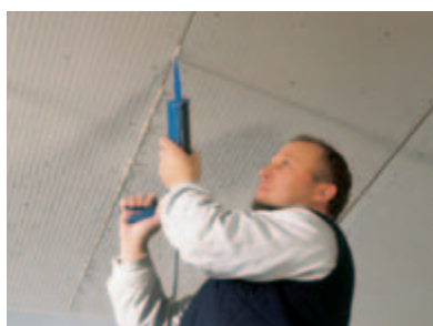
Fugen mit Handspritzpistole füllen ...
