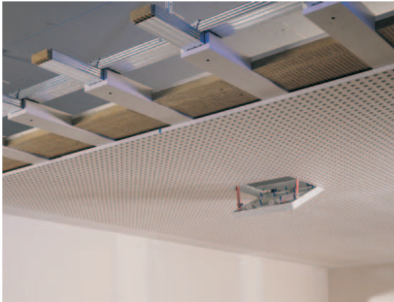
Geprüfter Brandschutz für Decken, bis F 90 – bei voller Gestaltungsfreiheit
