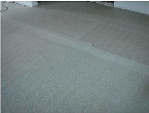
2) Pagitsch Trockenbaufußbodenheizung montieren
